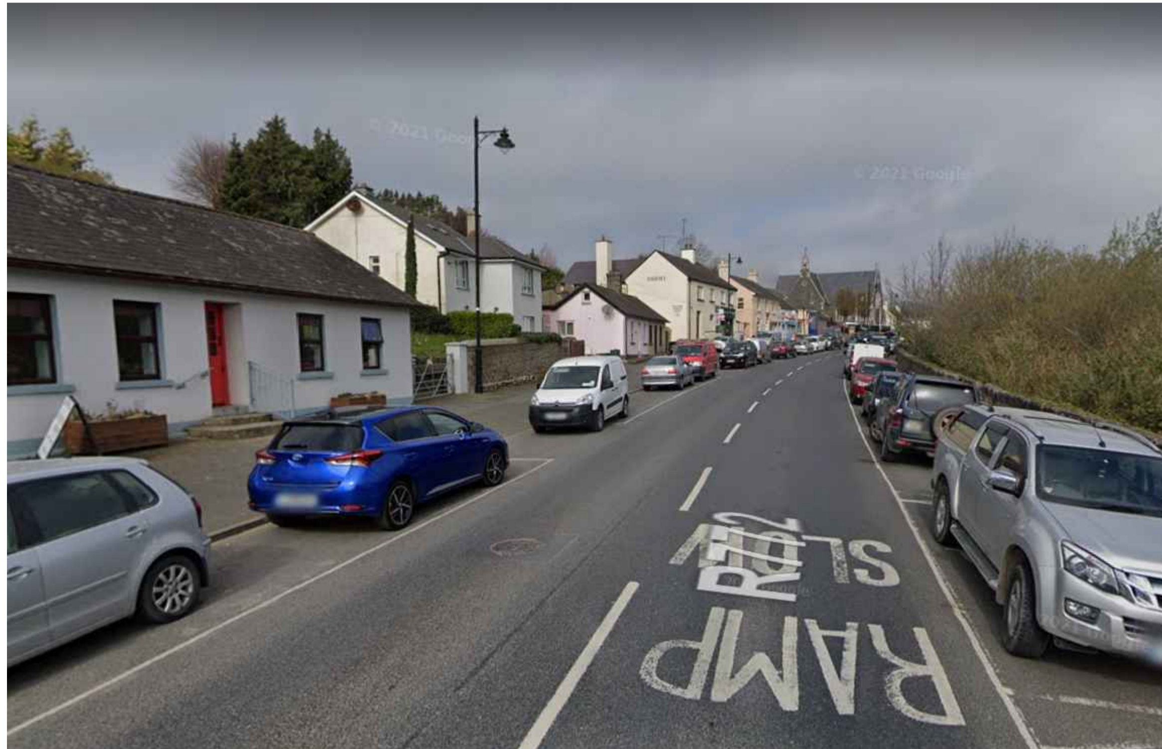
EXISTING ROAD - VIEW 02 N.T.S
